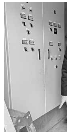
右図…地面から配電盤までの高さを確認
