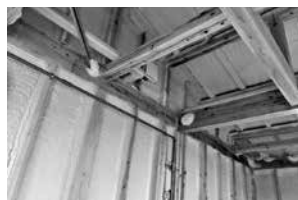
養父市産スキと断熱材を使用した建屋
