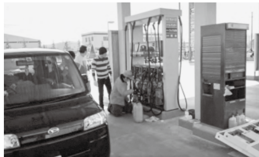
東日本大震災時には、ハンドルを手回してガソリンを地下タンクから汲み上げた。
