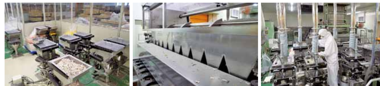
2階の加薬供給室と供給ホッパー。従来の装置よりホッパーの数が50%削減でき、さらにアレルギーを含む乾燥具材を別の系統に移動できた。 払出し装置の後の最終充填ホッパー。この部分も簡単に取り外しできるようになり時間短縮につながった。 女性作業員・新人が清掃している様子。コンベアからベルトが簡単に取り外せるようになった。
