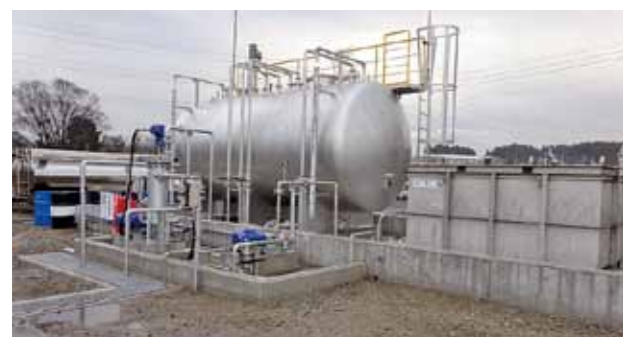
中和施設・ブレンド装置
