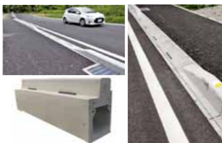
「SF側溝」を使用した道路
