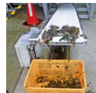
排出コンベアでのゴミ排出
