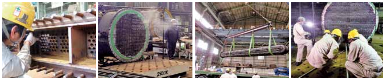
(図①) リチュービング作業の写真
