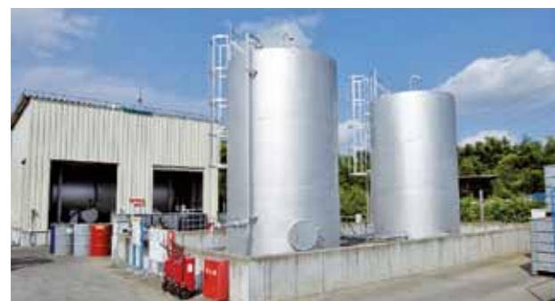
廃棄物中間処理施設及び屋外貯蔵タンク
