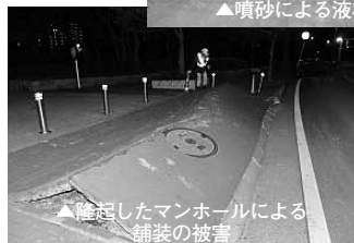
▲噴砂による液状化被害
