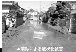
▲噴砂による液状化被害
